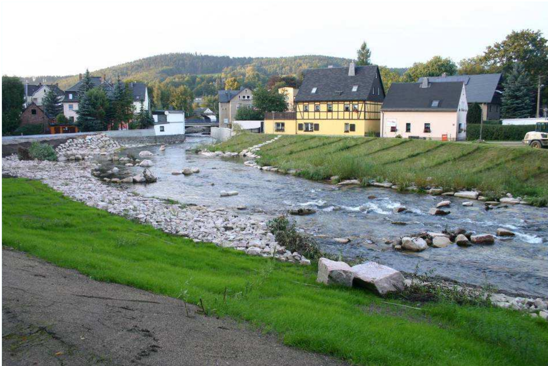
Schwarzenberg v Sasku – povodňové rozvolnění úseku koryta
