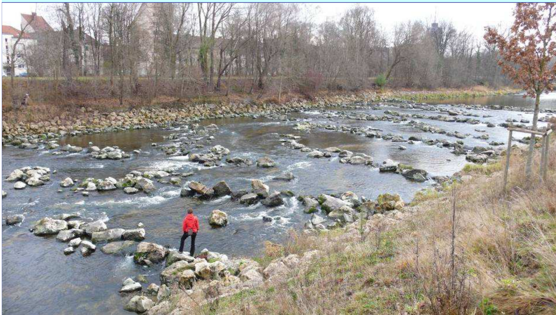
Augsburg – dnová rampa v místě zrušeného jezu Goggeles
